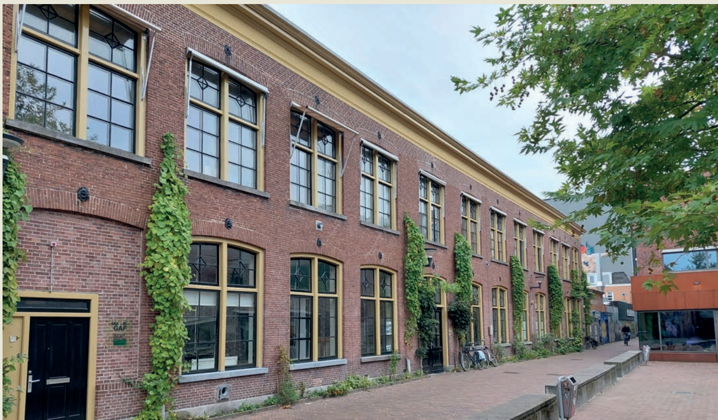
De Haniasteeg in Leeuwarden met het voormalige Stads Armenhuis. Hier verbleven onder andere Johanna en Rutje Tolhuis. Het huidige pand stamt uit 1879 en verving het in 1831 gebouwde armenhuis. Foto door auteur.
