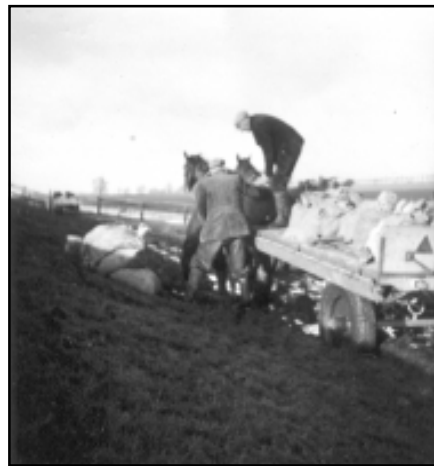
Versterking van de dijk langs het veendiep (1959/1960)
