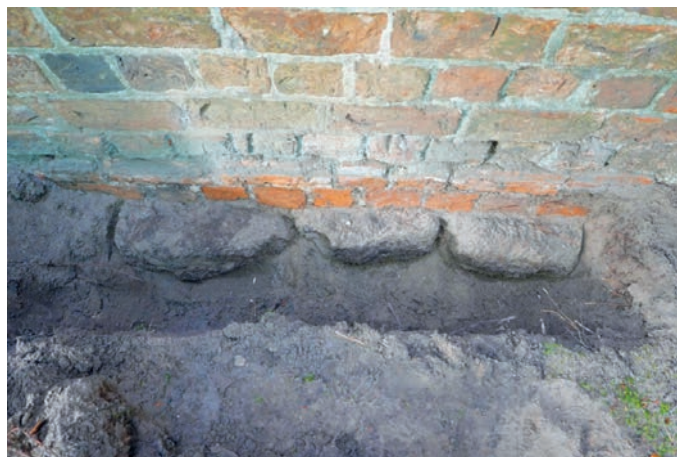
Fundering van blokken ijzeroer onder de kerkmuur. Foto: Jim Klingers.
