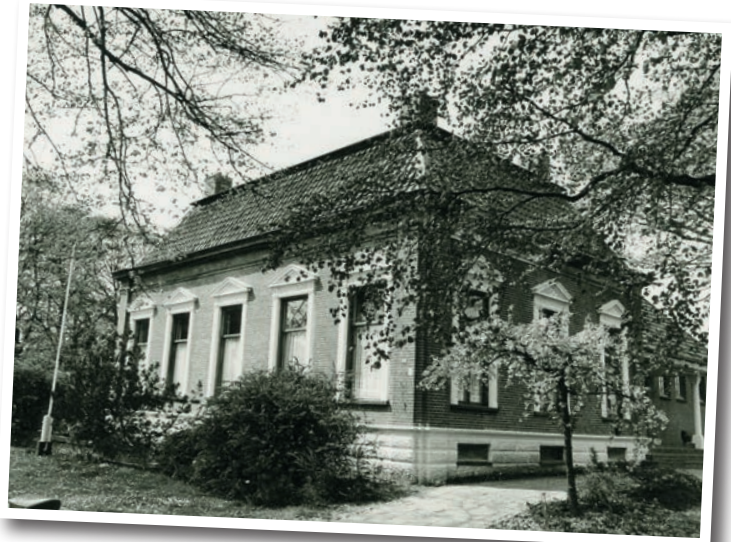
↑ Voormalige openbare lagere school in Oudeschans, 1974. Foto: M.A. Douma Collectie Groninger Archieven.
