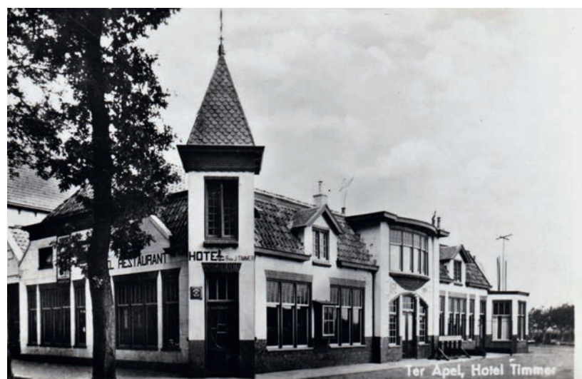
Hotel Timmer kreeg in 1920 het statige torentje. Het gebouw staat nog steeds in Ter Apel, maar heeft al lang geen hotelfunctie meer.
