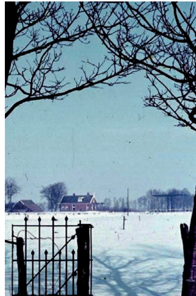
De brugwachterswoning bij Harpelsluis. Foto genomen in de buurt van de boerderij van Harberten Have (thans 'Harberts Hoeve'), dus vanaf de Oostzijde van het Mussel-Aakanaal. Brug en sluis zijn verdwenen, de eiken langs het kanaal moesten nog geplant worden. Jaartal onbekend. Foto: collectie Harpel on-line.
