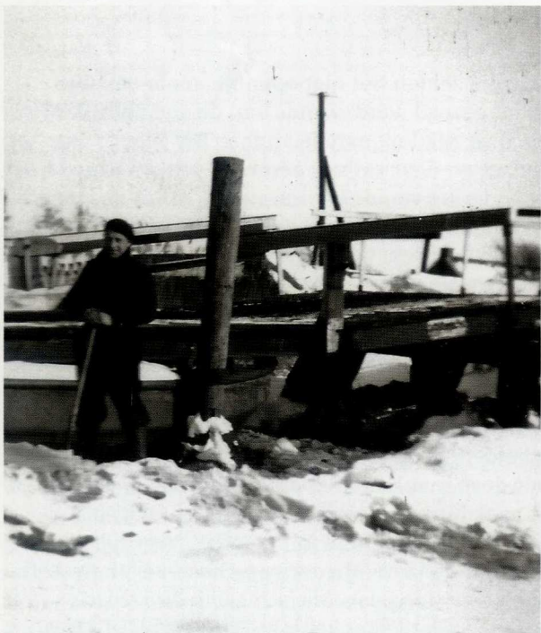
De pontonbrug in 1947. Foto: collectie Harm Scholte.
