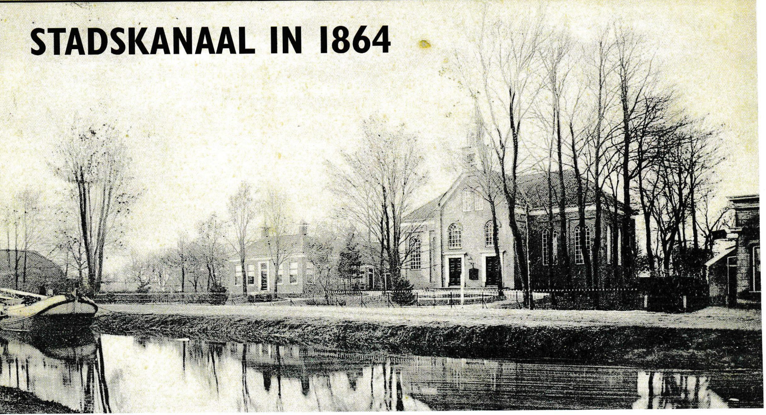
De Hervormde kerk aan de Oosterkade, volgens Tichelaar in 1862 als 'eene nette sierlijke kerk en pastorie gebouwd bij den mond van Nieuw-Buinen.' Collectie Streekhistorisch Centrum
