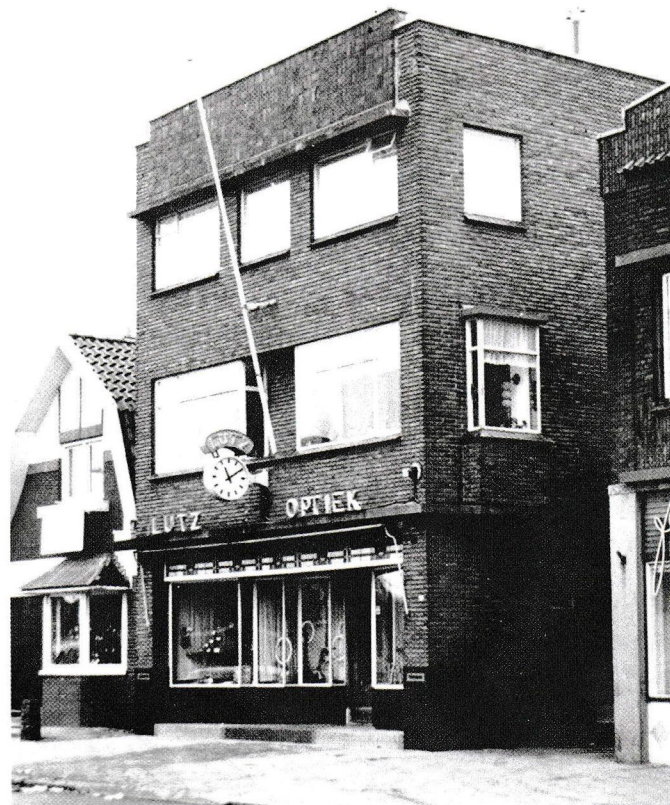
Pand aan de Hoofdstraat 29B Foto: persoonlijk archief van de auteur
