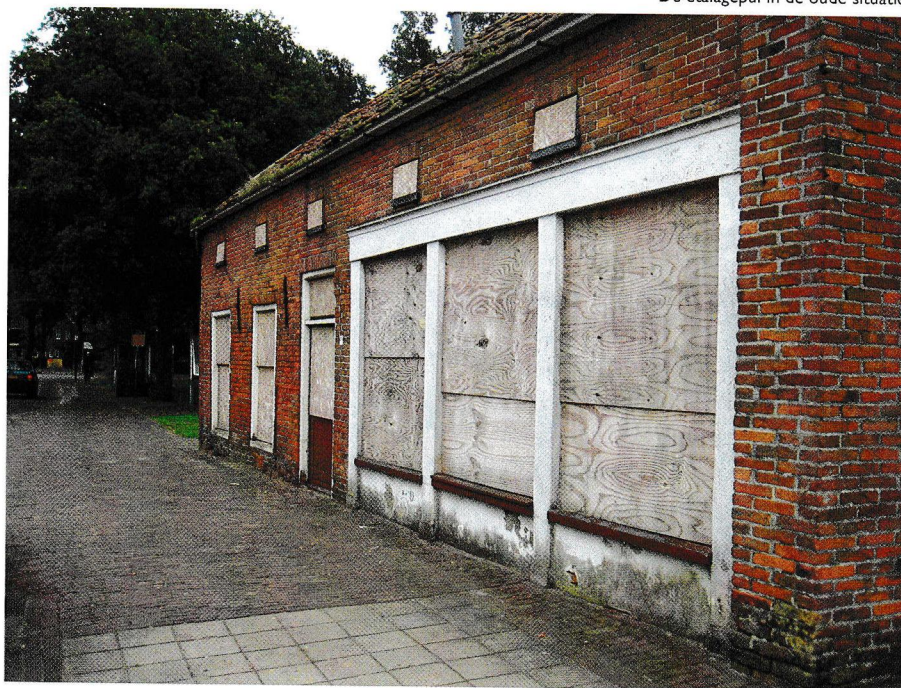
De etalagepui in de oude situatie.
