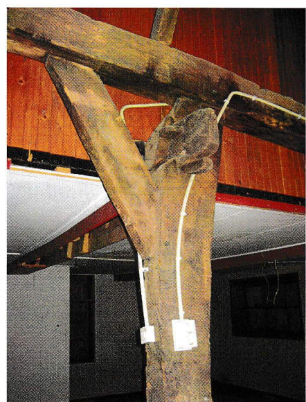
Eén van de ankerbalkgebinten met een praktische oplossing: de stijl dient tevens als schoor, omdat hij niet recht is.
